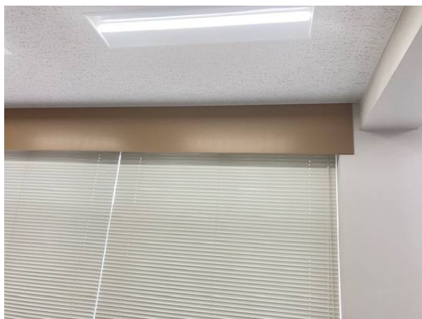
空調機取付前
