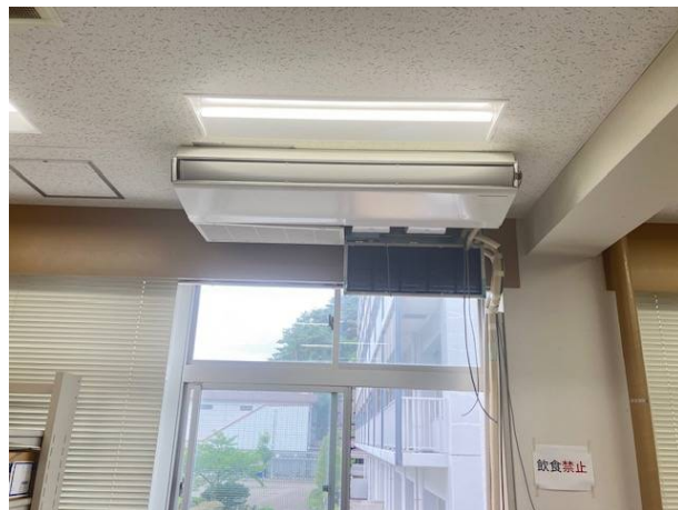
天吊り型空調機取付
